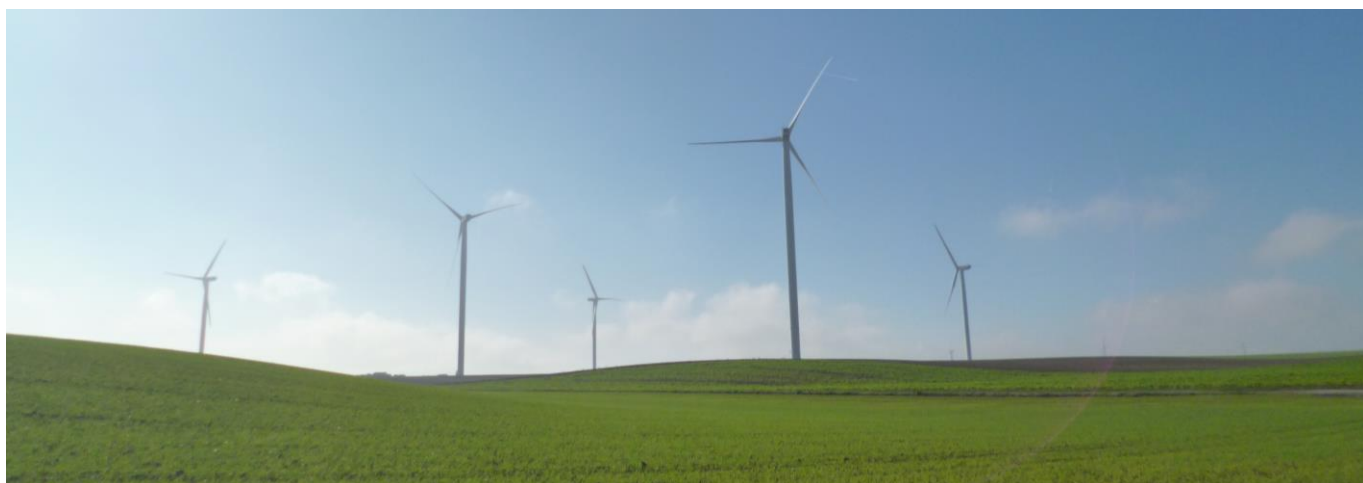
Figure 1 : Parc éolien de Terre de Beaumont dans le département de l'Aisne, projet porté par wpd (Source : wpd onshore France)
