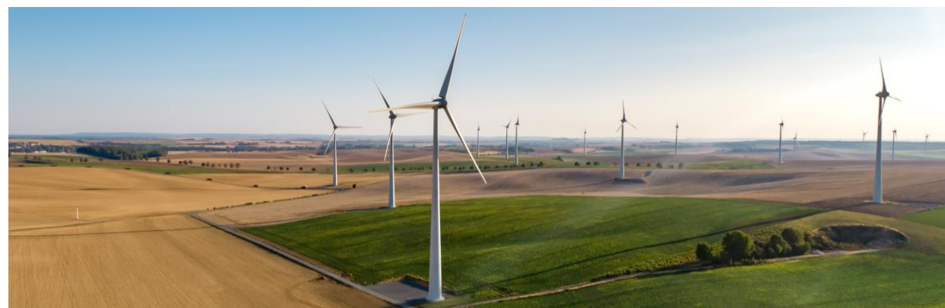
Figure 2 : Parc éolien de Champcourt dans le département de l'Aisne, projet porté par wpd (Source : wpd onshore France)
