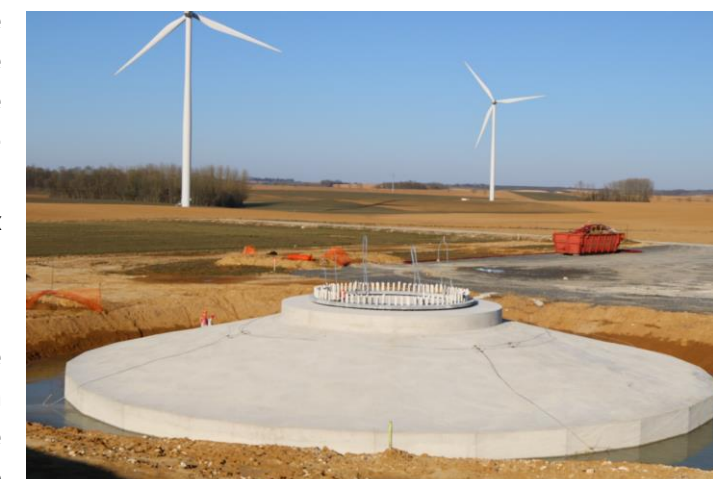
Fondation avant recouvrement
